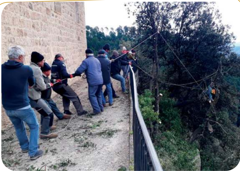
Chantier collectif d'élagage des chênes
