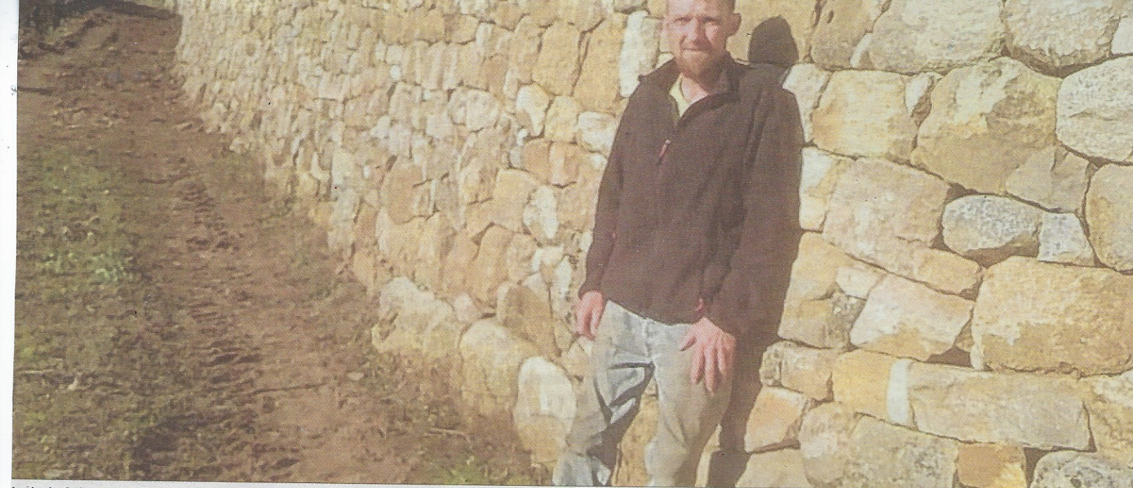
Ludovic Salvar, un artiste du mur en pierre qui n'utilise pas de béton.
