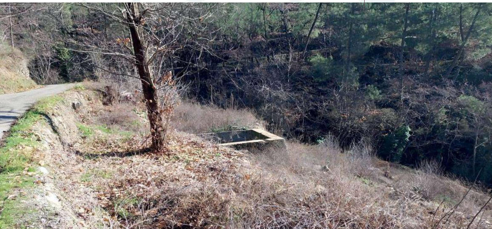
Une prise d'eau placée dans le ruisseau du même nom, permettait d'alimenter le réseau. Une canalisation constituée de tubes de fer d'une longueur d'un mètre et cinq centimètres de diamètre, et raccordés au moyen d'un ingénieux système de brides et clavettes fut posée, enterrée, par tronçon jusqu'à la fontaine de l'"Aubezon", qui permettait d'offrir de l'eau à ce hameau.
